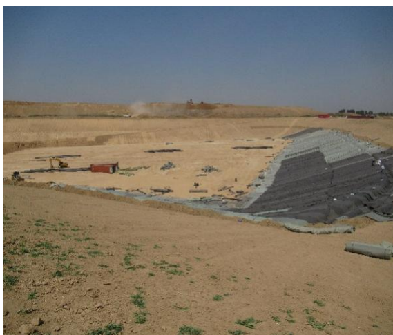
Рис. 13 Укладка геотекстиля (09.06.2023)
